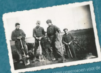
Eenkele spijters die werden opgeroepen voor de aanleg van kades.
