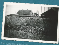
Een twee meter hoge dijk rond de boerderij van Jan van Waaai aan de Middelweg 3 bij Hazerswoude. Op de achterkant van de foto staat geschreven: '3 tot 10 maart 1944, 1,7 km dijk aangelegd'.
